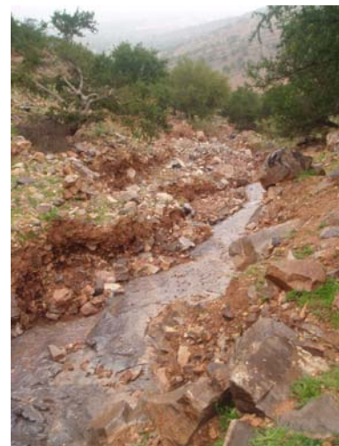
Photo 6 : Erosion régressive due aux ravines des versants du piémont de l'Anti-Atlas
